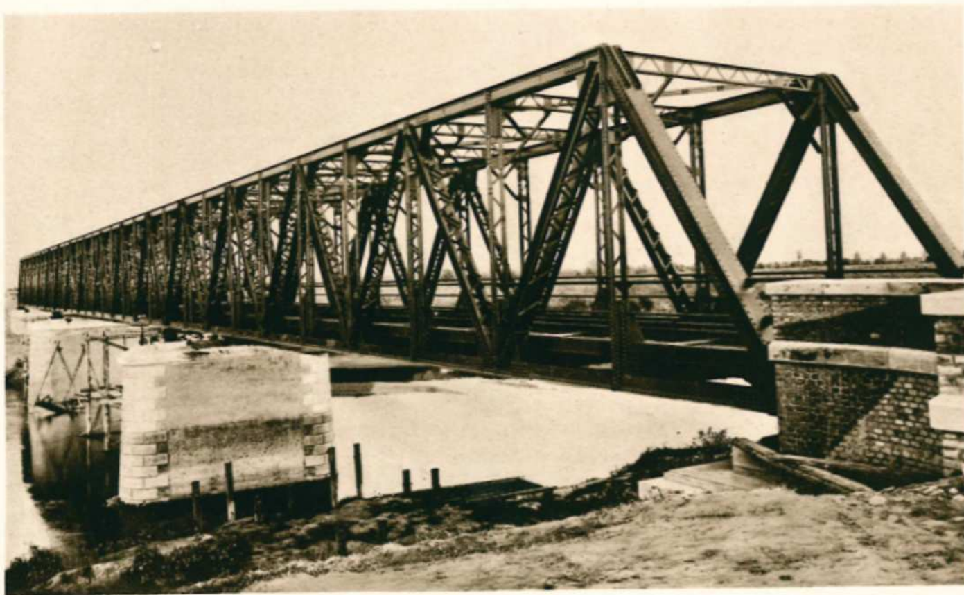
Il ponte sul Brenta.
