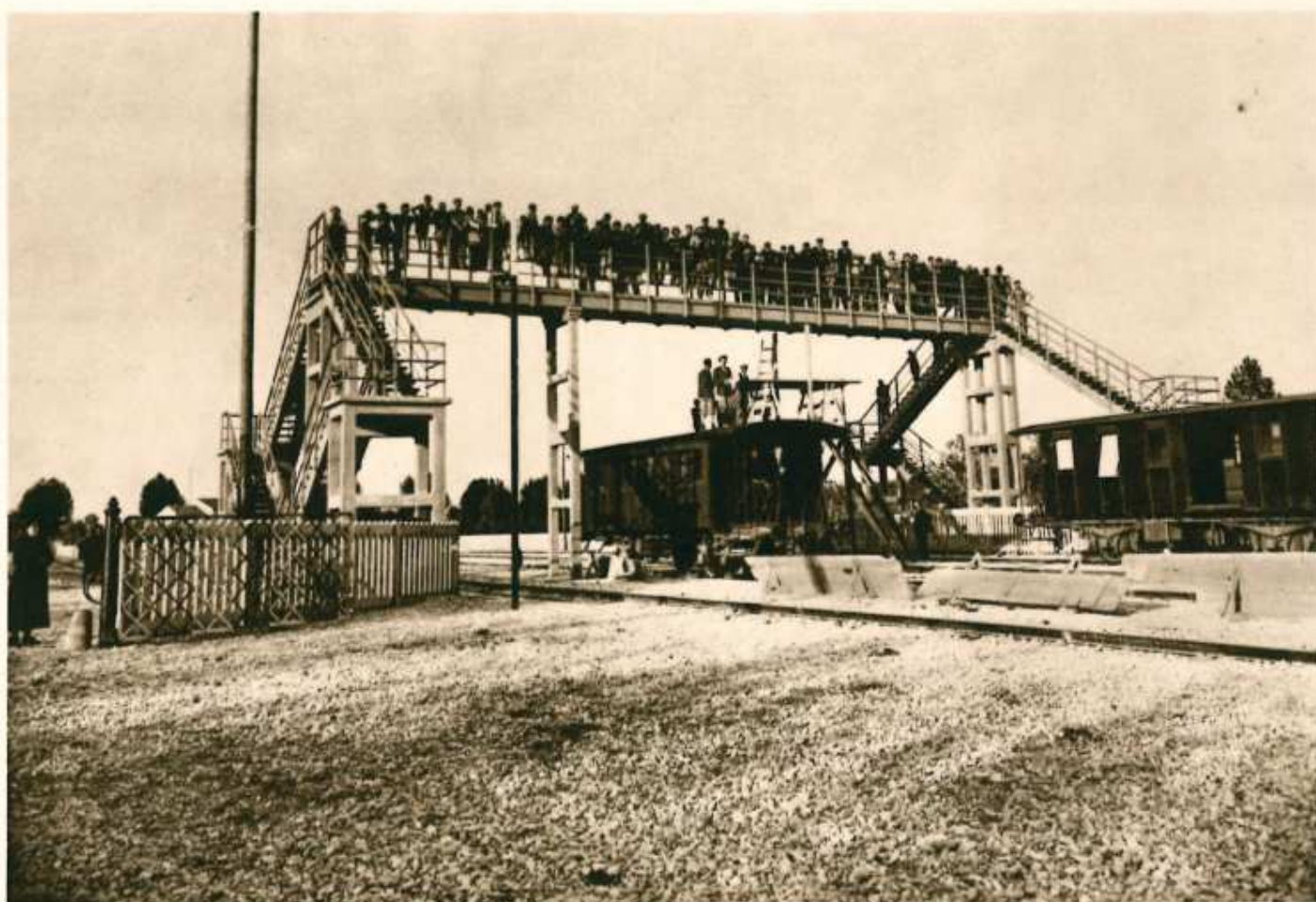
Il soprapassaggio alla stazione di Piove.
