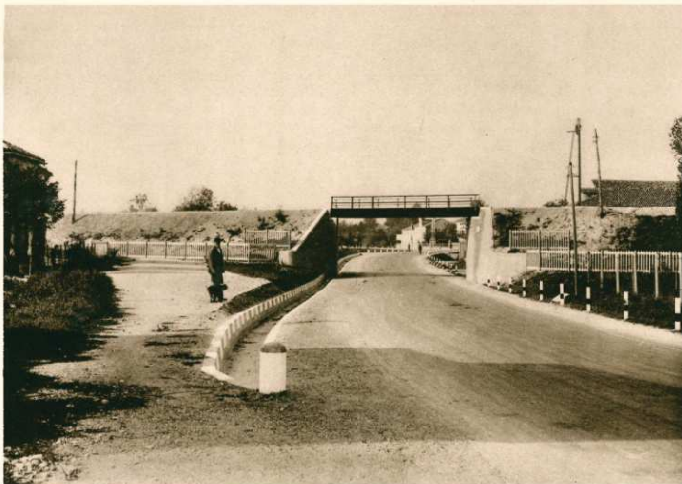
Attraversamento Strada Nazionale Padana Superiore in località Gambarare.
