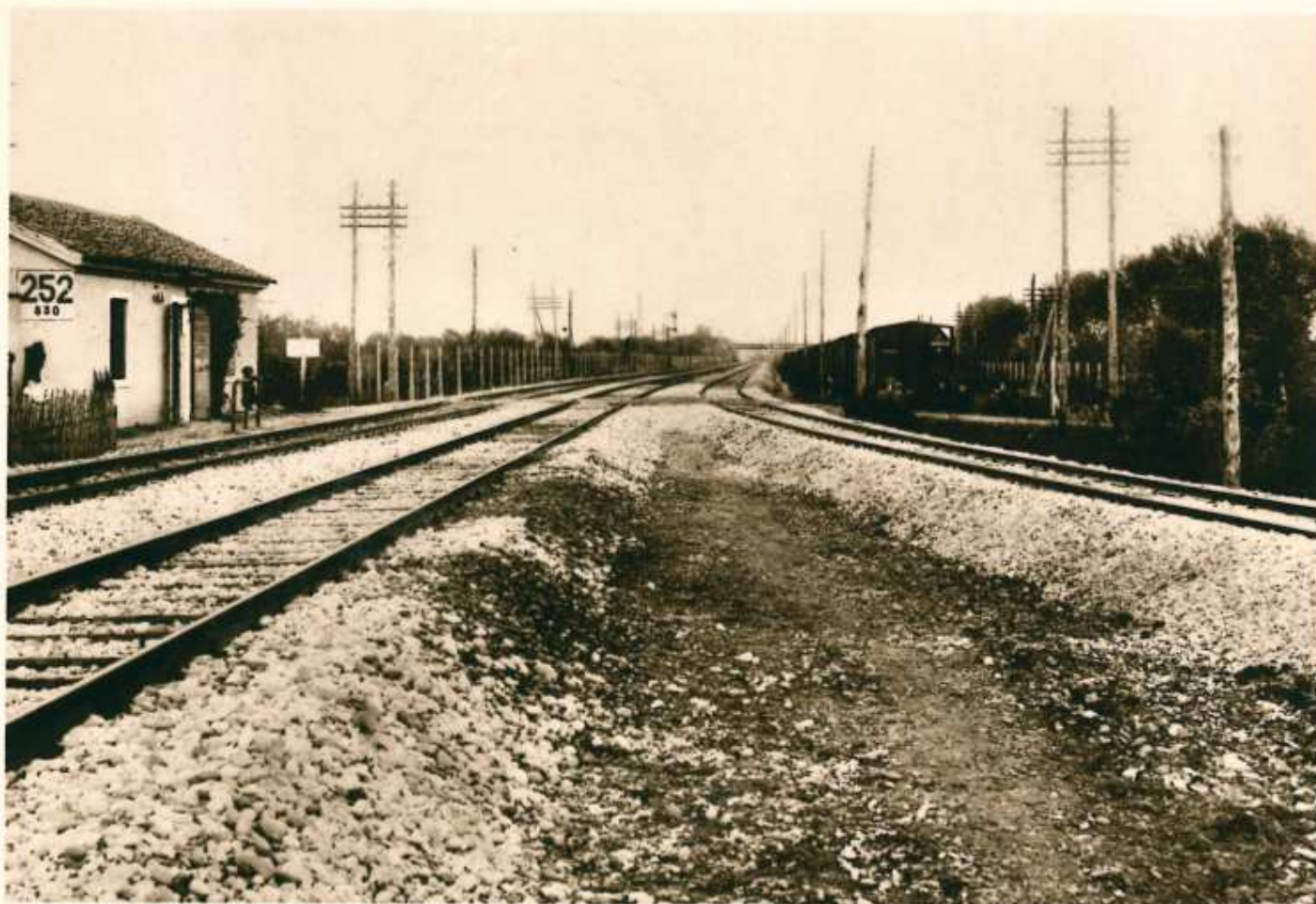
Allacciamento alle Ferrovie dello Stato, all'inizio del piazzale della stazione di Mestre, in località Chirignago.
