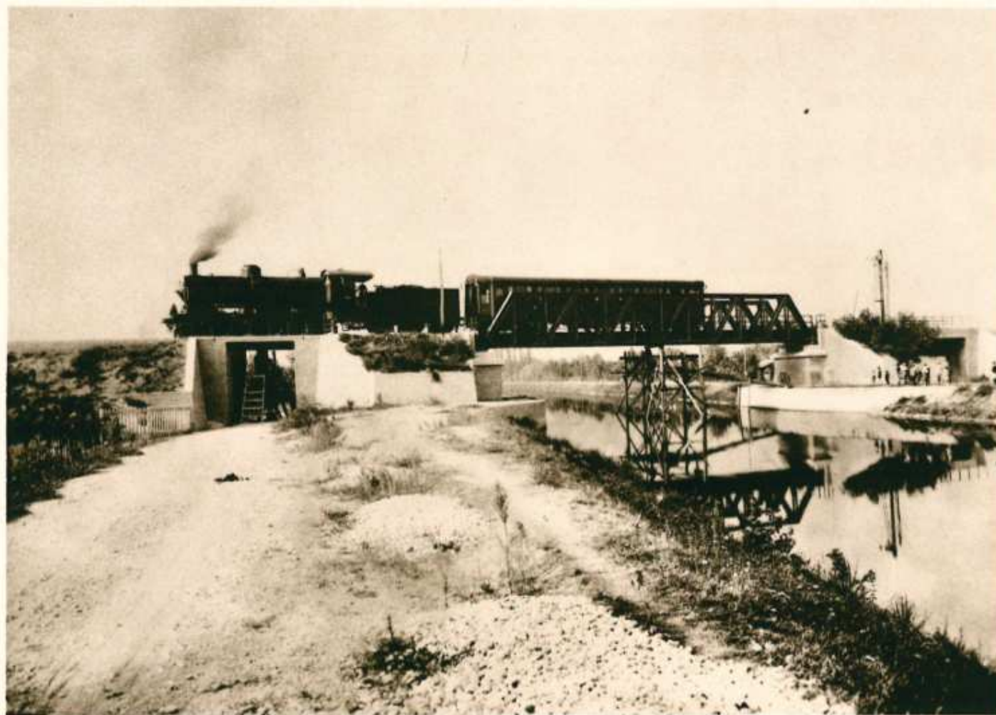
Prove di carico lungo la linea.
