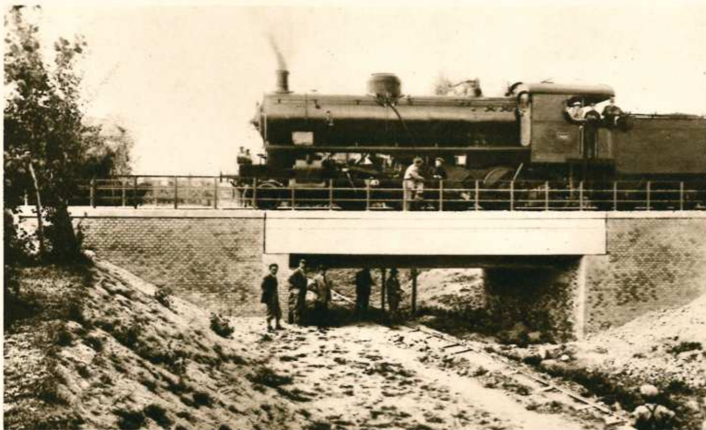
Prove di carico lungo la linea.
