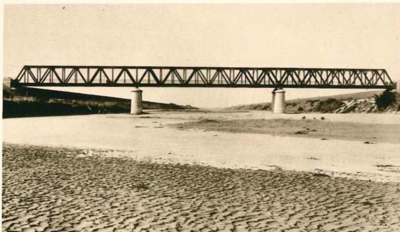
Il ponte sul Brenta visto dall'alveo del fiume.
