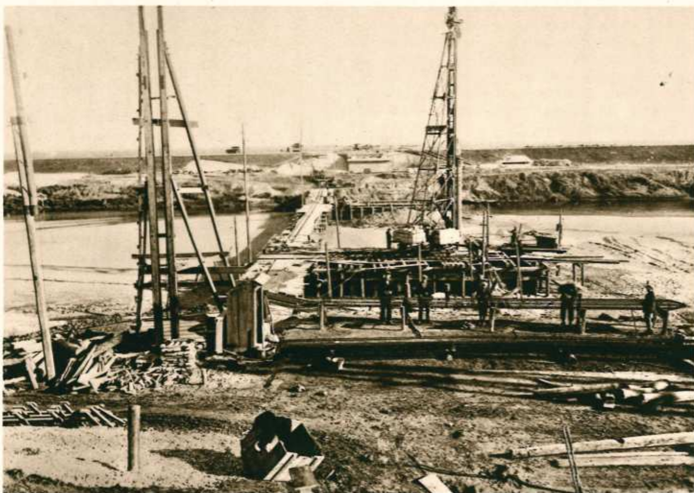
Durante i lavori di costruzione del ponte sul Brenta.
