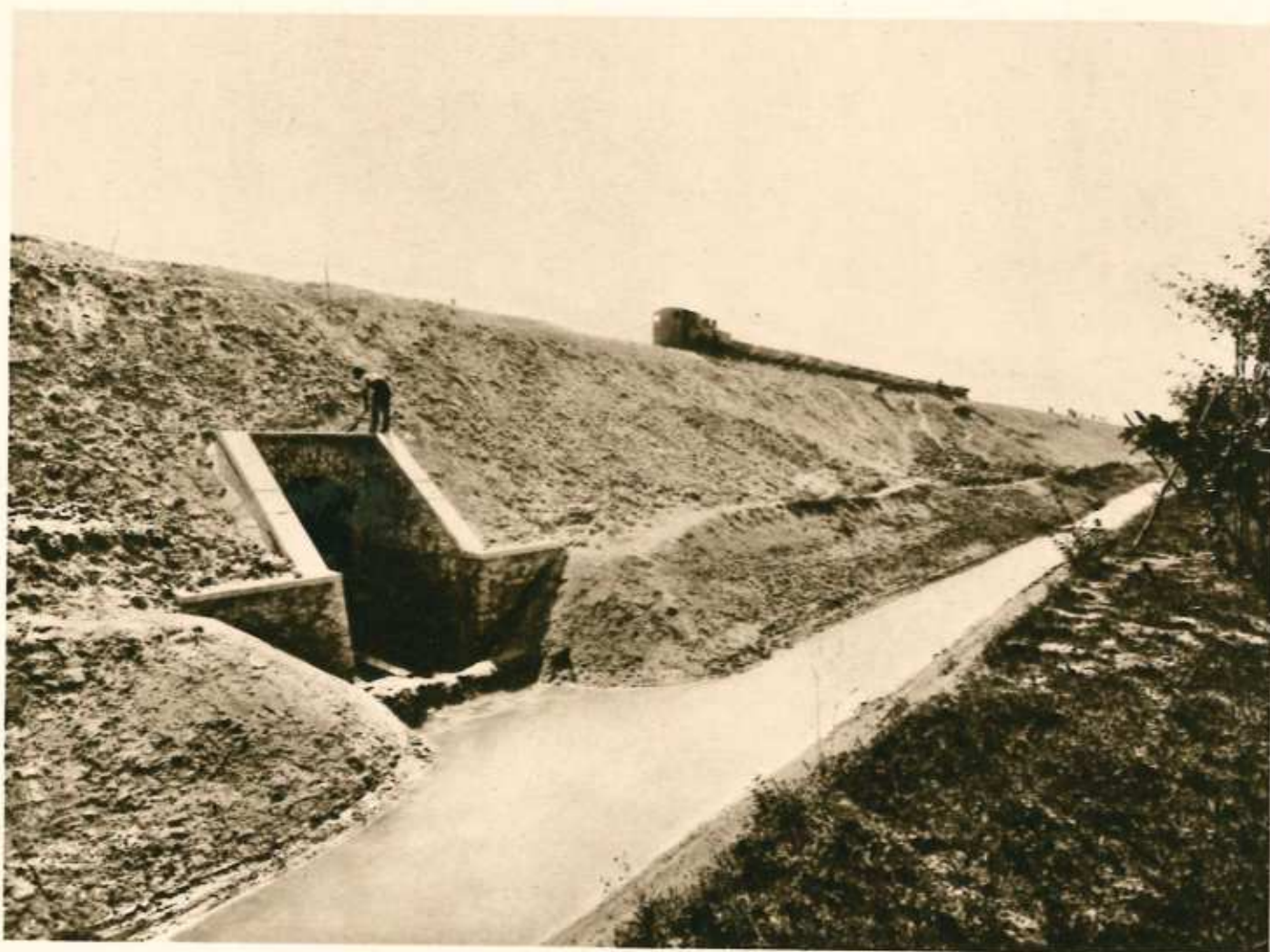
Il terrapieno della rampa sinistra del Brenta durante i lavori.
