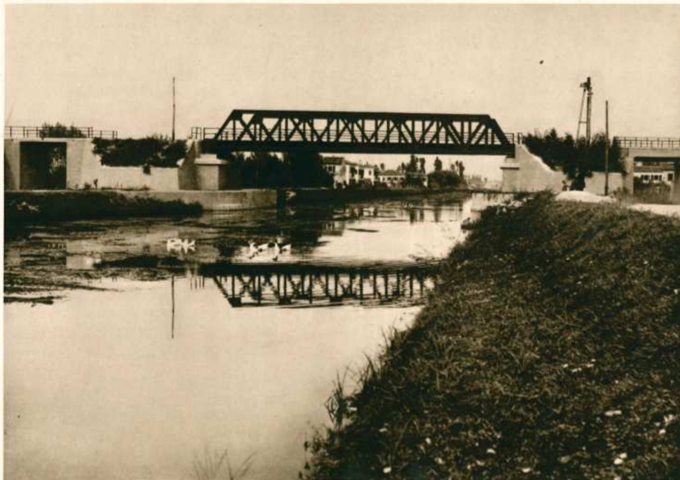
Attraversamento del Nuovissimo.
