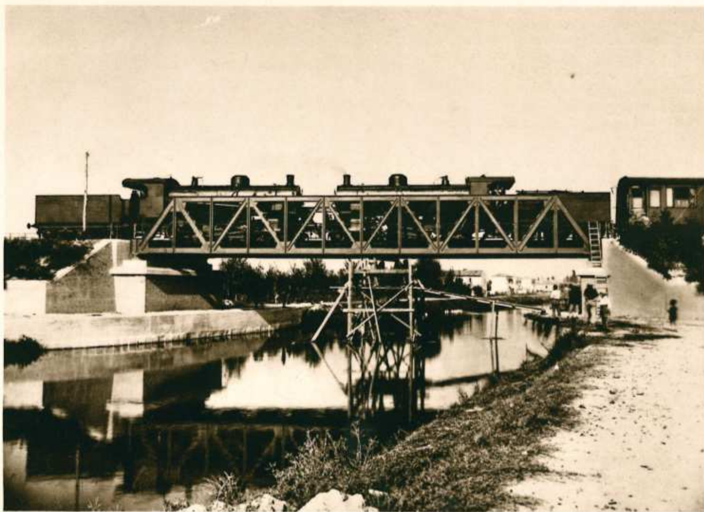
Prove di carico lungo la linea.
