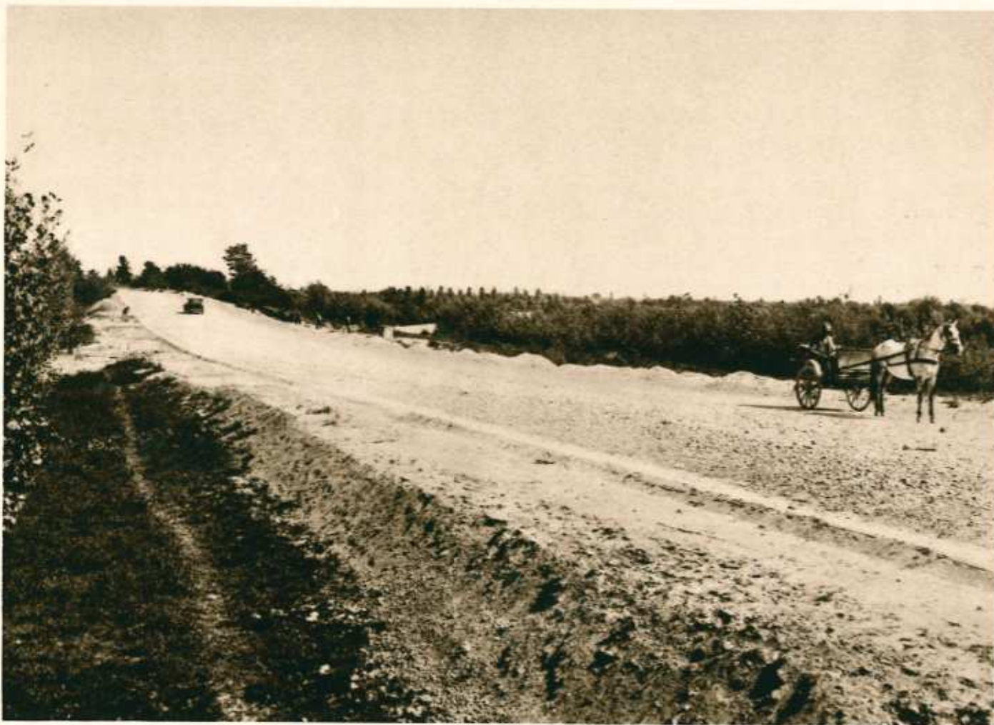
I lavori per il passaggio a livello della strada provinciale a S. Bruson.
